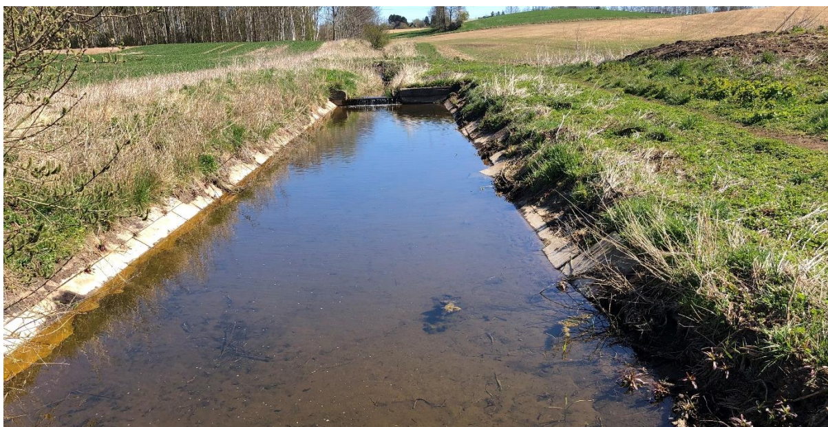
Figur 2-10: Sandfanget fremstår som et større teknisk anlæg med støbte sider og kanter.
